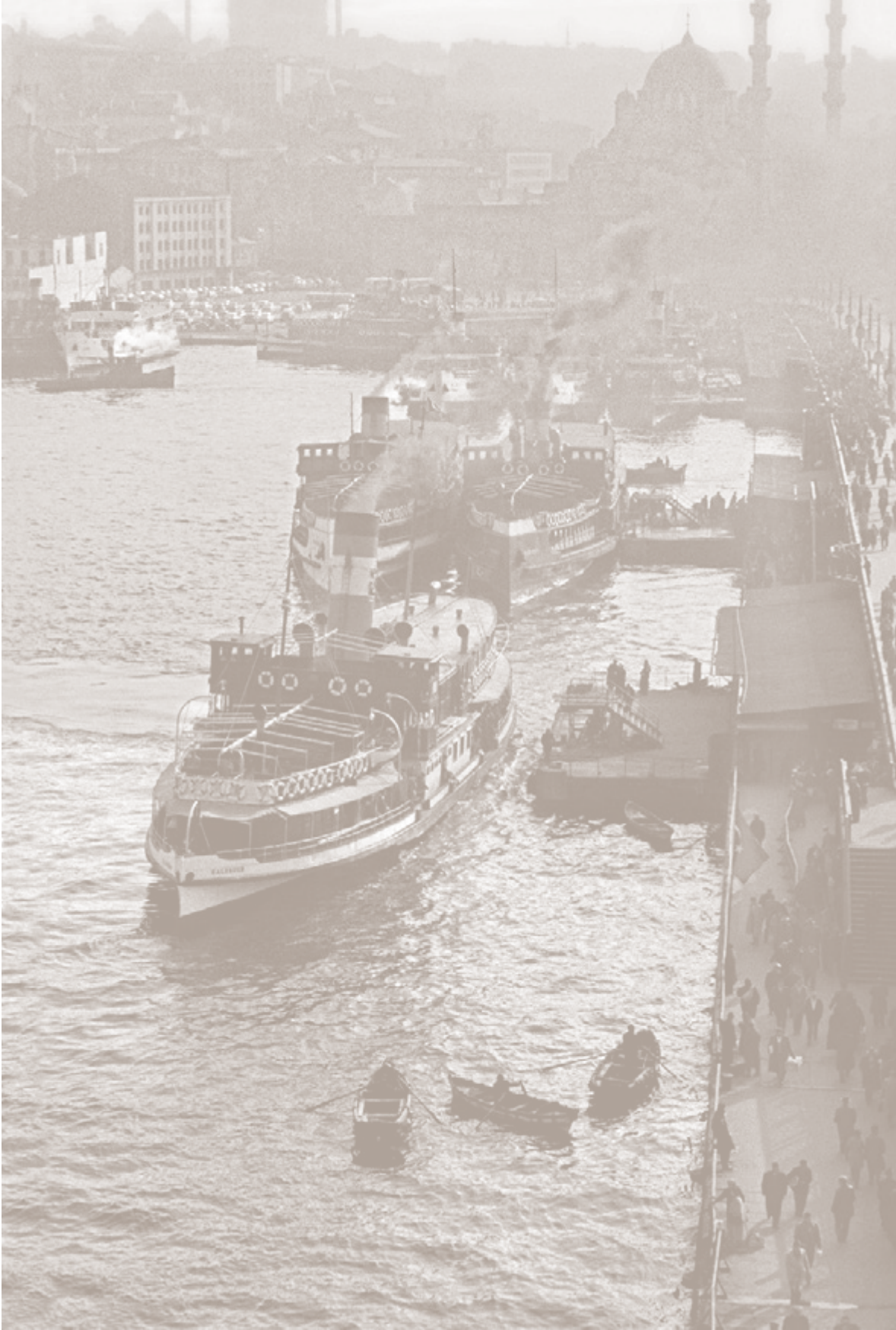
Galata Köprüsü üzerinde iskeleler, 1958
